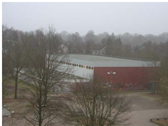
Dachaufsicht Turnhalle, aus NW
