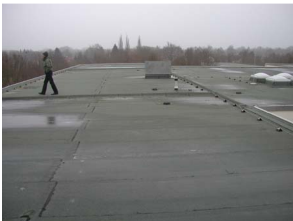
Teilansicht Dach Schulgebäude, aus NW
